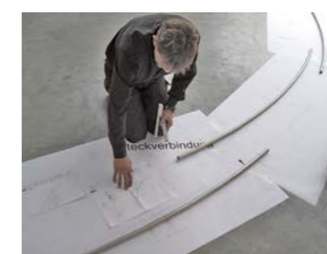
Der gefertigte Laufschienebogen wird bei der Montage passgenau auf der Techn Zeichnung ausgelegt und mit ihr abgeglichen.
