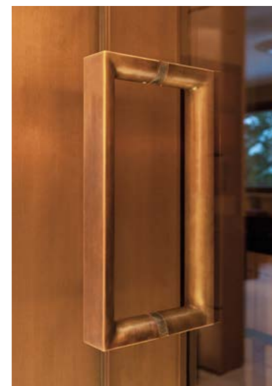
Sondertürgriff aus brüniertem Messing Special door handle made of burnished brass
